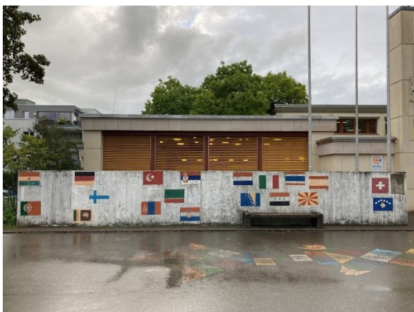
Die Wand vorher
