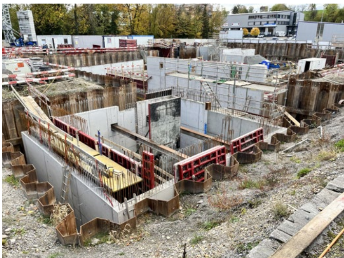
Die Arbeiten für den Ausbau der Abwasserreinigungsanlage Flos sind in vollem Gange.
